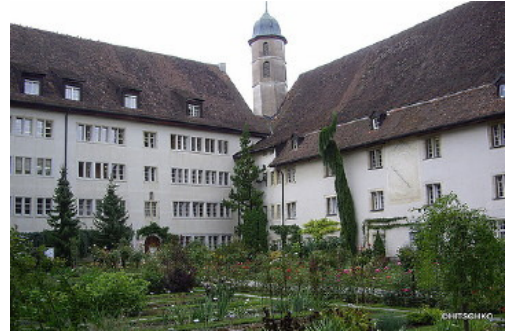
Lycée cantonal de Porrentruy
